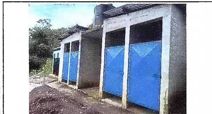
Foto 7: MODULO 3 SERVICIOS SANITARIOS: Mantenimiento a estructura (lijado, cambio de tubo , cepillado, sujeciones, aplicación de pintura) a puertas servicios sanitarios
