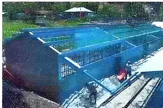
Foto 2: MODULO 1: Mantenimiento a estructura de soporte de metal
