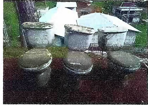
Foto 8: MODULO 3 SERVICIOS SANITARIOS: Sustitución inodoro
