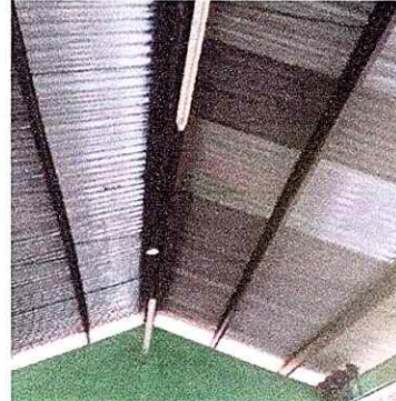
Foto 2: MODULO 1: Mantenimiento a estructura de soporte de metal
