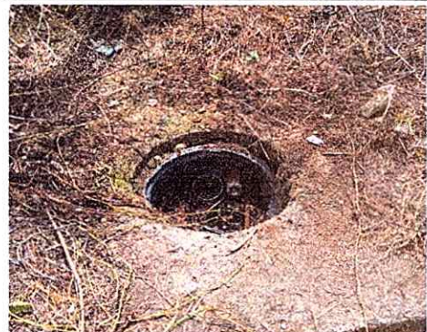
Foto 10: MODULO 3 SERVICIOS SANITARIOS: Reparación de tapaderas de cajas
