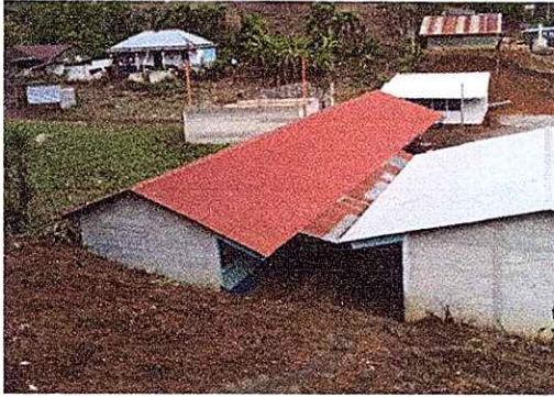
Foto1: MODULO 1: Sustitución de lámina, por lámina troquelada
