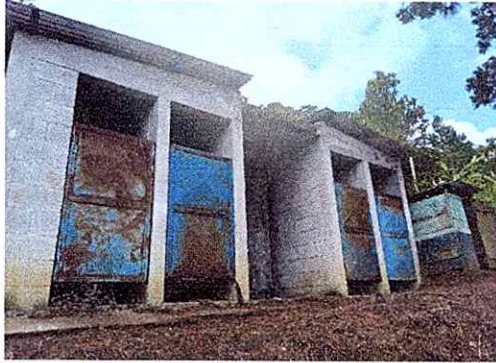
Foto 7: MODULO 3 SERVICIOS SANITARIOS: Mantenimiento a estructura (lijado, cambio de tubo , cepillado, sujeciones, aplicación de pintura) a puertas servicios sanitarios
