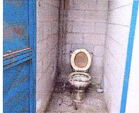
Foto 8: MODULO 3 SERVICIOS SANITARIOS: Sustitución inodoro
