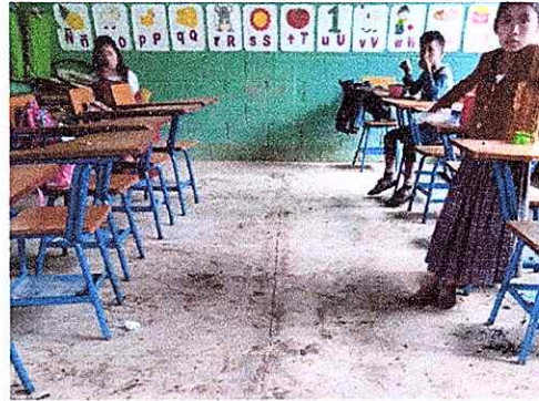
Foto 4: MODULO 1: Sustitución de piso de granito
