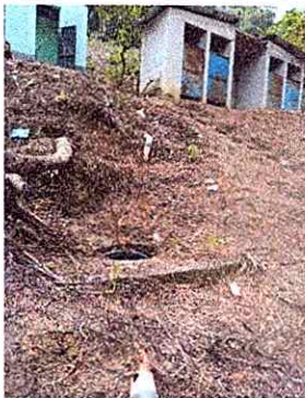
Foto 9: MODULO 3 SERVICIOS SANITARIOS: Limpieza de fosa séptica
