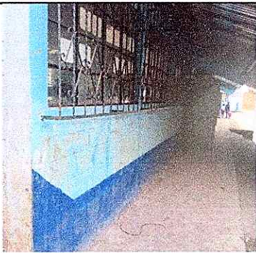
Foto 5: MODULO 1: Pintura en muros exteriores e interiores
