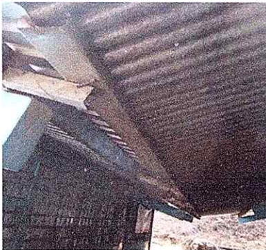
Foto 3: MODULO 1: Sustitución de bajada de agua pluvial de metal por tubo PVC 4"
