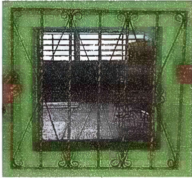
Foto 1 Módulo 1: Suministro e instalación de balcon de metal en ventanas
