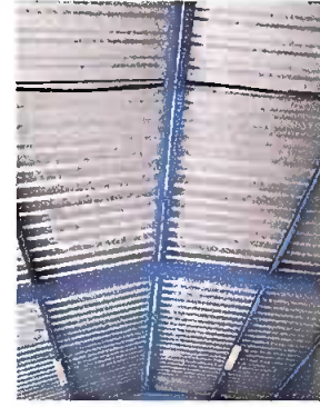
Foto 2: Sustrucción de láminas calibre 26
