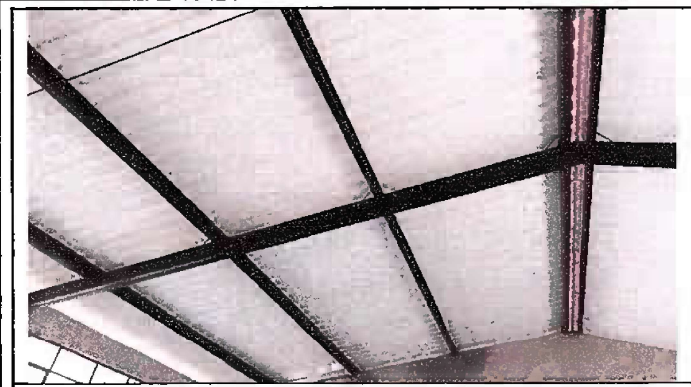
Foto 1: MODULO 1 Sustitucion de lámina, Por Lamina Troquelada aluzinc calibre 26
