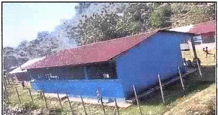
Foto 4: MODULO 1 pintura de muros interior y exterior
