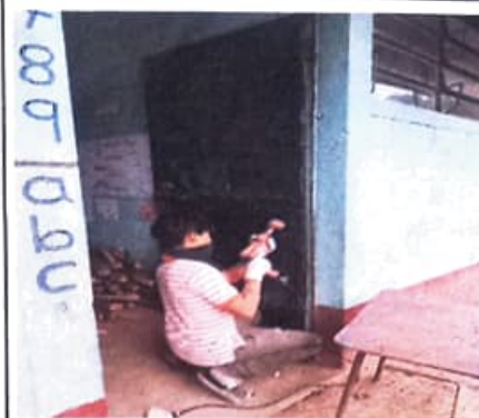
Foto 2: sustitucion de puertas de aulas
