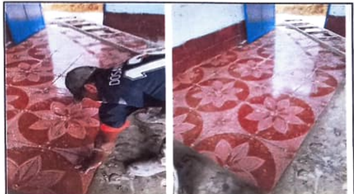
Foto 4: sustitución de piso interno de las aulas
