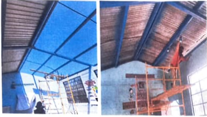
Foto1: sustitución de techo
