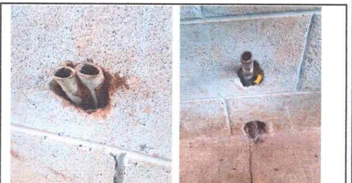
Foto 4: sustitucion de instalación electrica
