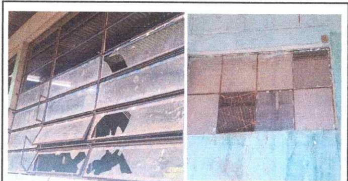
Foto 3: sustitución de vidros
