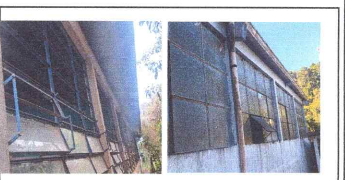
Foto 6: aplicación de pintura
