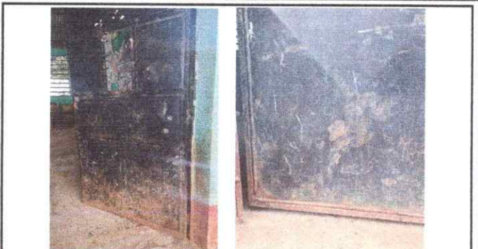
Foto 2: sustitucion de puertas de aulas
