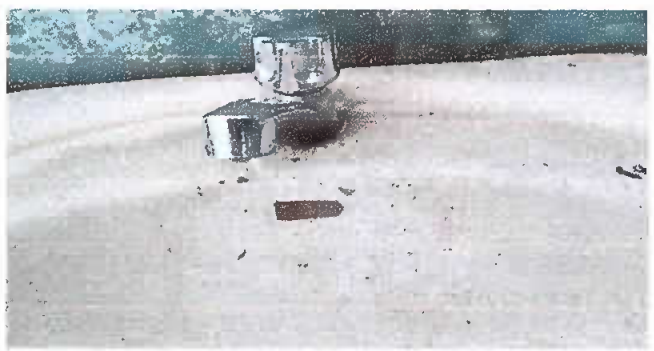
Foto 6: sustitucion de llaves
