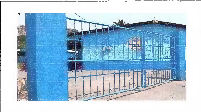
Foto 1: mejomiento de porton de la entrada principal.
