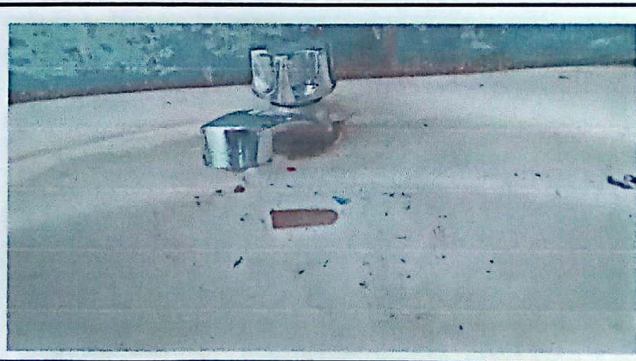
Foto 6: sustitucion de llaves
