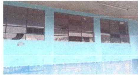
Foto 2: cambio de vidrios (270)
