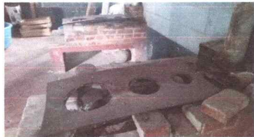
Foto 4: cambio de planchas en la cocina (3)
