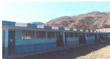
Foto 6: construccion de aulas 2do nivel (8)
