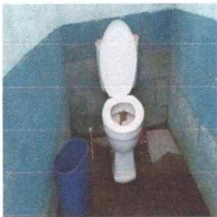
Foto 5: cambio de losas sanitarias(12)
