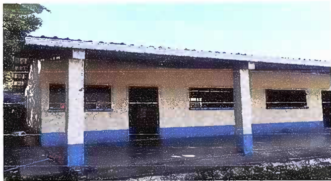
Foto 3: MODULO 1 MANTENIMIENTO A ESTRUCTURA DE TECHO
