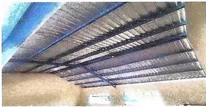
Foto 1: MODULO 1 SUSTITUCION DE LAMINA POR LAMINA TROQUELADA CALIBRE 26
