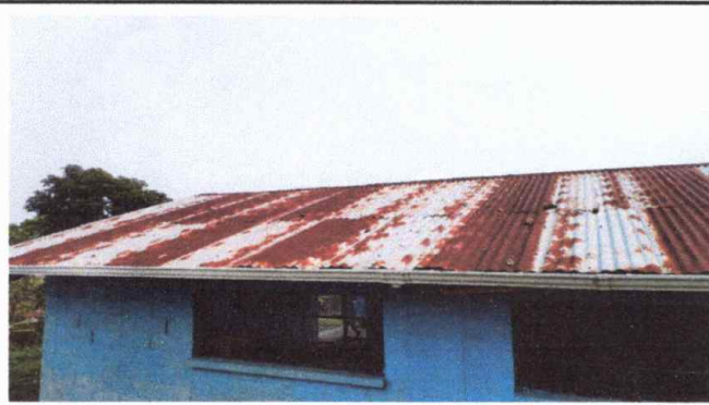
Foto1: MODULO 1 SUSTITUCION DE LAMINA POR LAMINA TROQUELADA CALIBRE 26
