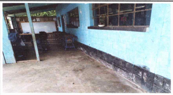
Foto 2: MODULO 1 MANTENIMIENTO A VENTANAS
