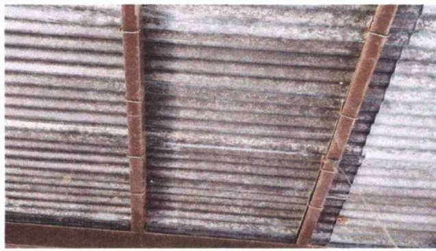
Foto 3:MODULO 1 MANTENIMIENTO A ESTRUCTURA DE TECHO
