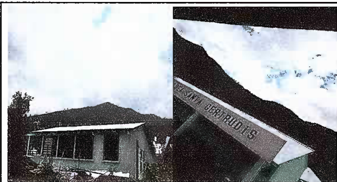
Foto1: Sustitucion de Laminas
