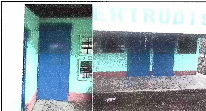
Foto 2: Mantenimiento de puertas
