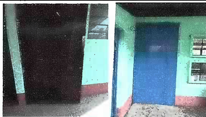
Foto 2: Mantenimiento de puertas
