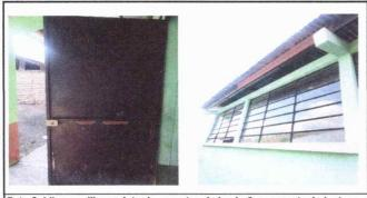
Foto 5: Lijar, cepillar y pintar las puertas de los baños y mantenimiento a estructura de metal (costanera)
