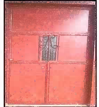
Foto 2: MÓDULO 1 Mantenimiento a estructura de puerta (lijado, cambio de tubo, cepillado, sujeciones, aplicación de pintura)
