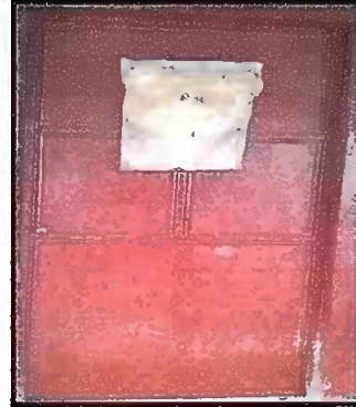
Foto 2: MÓDULO 1 Mantenimiento a estructura de puerta (lijado, cambio de tubo, cepillado, sujeciones, aplicación de pintura)
