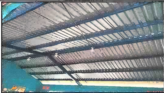
Foto 3: MÓDULO 1 Mantenimiento a estructura de soporte de metal
