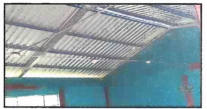
Foto 6: MÓDULO 1 Sustitución de estructura de soporte de madera, por metal
