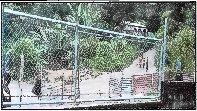
Foto 9: MURO PERIMETRAL Reparación de muro perimetral de block con tubo hg y malla galvanizada, soleras intermedias y columnas.
