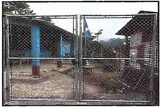
Foto 11: MURO PERIMETRAL Sustitución de portón de metal.
