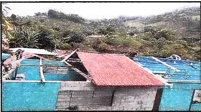
Foto 3: MÓDULO 1 Mantenimiento a estructura de soporte de metal
