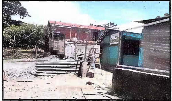
Foto 10: MURO PERIMETRAL Fabricación e instalación de portón de metal de ingreso
