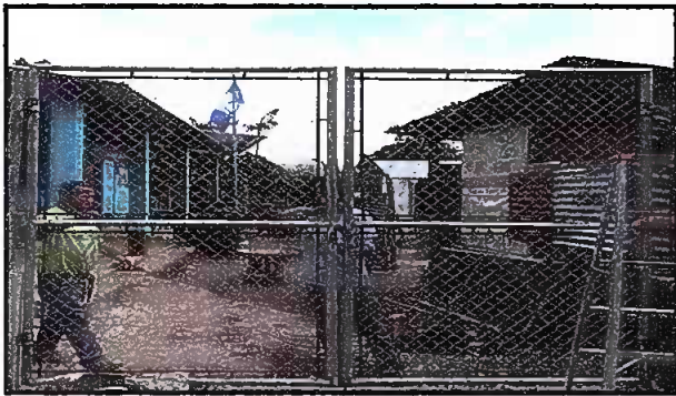
Foto 11: MURO PERIMETRAL Sustitución de portón de metal.
