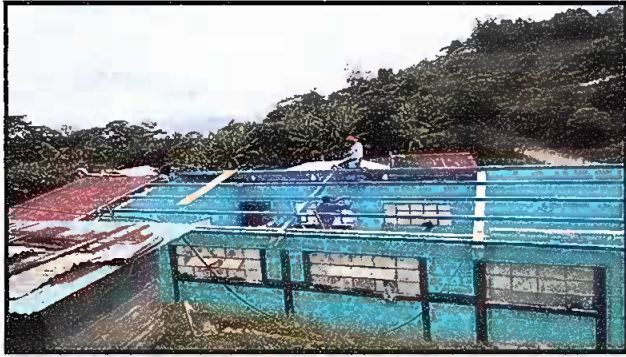
Foto1: MÓDULO 1 Sustitución de lámina, por lámina troquelada alizinc calibre 26
