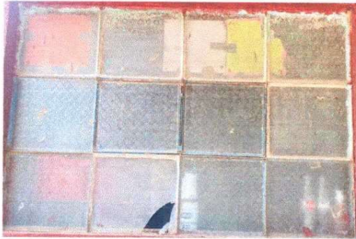
Foto 7: MÓDULO 1 sustitución de vidrios
