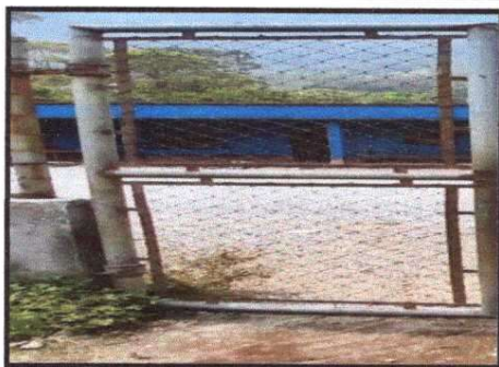
Foto 11: MURO PERIMETRAL Sustitución de porton de metal
