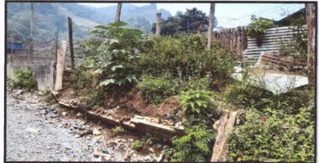
Foto 8: MURO PERIMETRAL Reparación de muro de contención
