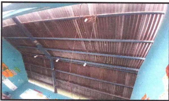
Foto 3: MÓDULO 1 Mantenimiento a estructura de soporte de metal
