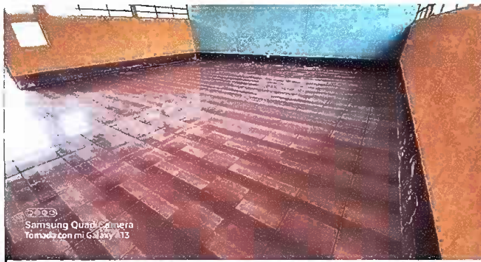
Foto 5: Sustrucción de piso en las aulas
