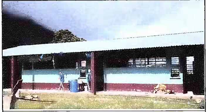
Foto 2: Sustrucción de lámina
