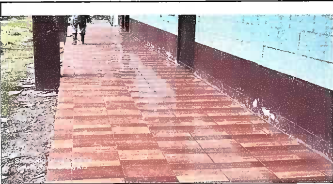
Foto 1: Sustrucción de piso en el área del corredor
