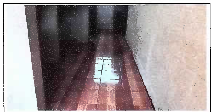
Foto 6: Sustrucción de piso en área de los sanitarios
