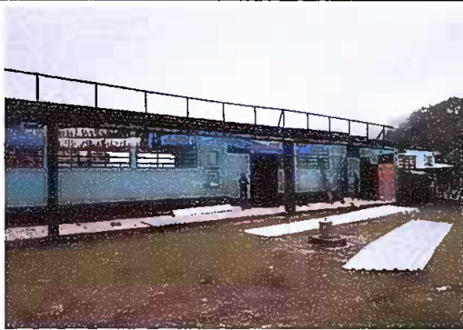
Foto 3: Trabajos de Sustitución de
