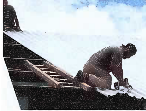
Foto 2: Trabajos de Sustitución de lámina
