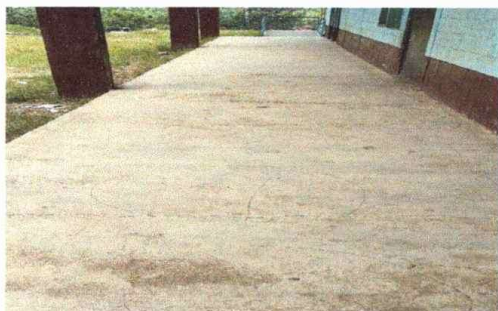
Foto 3: módulo 1 sustitución de piso cerámico
