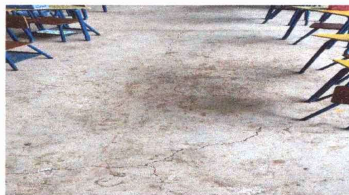
Foto 2: módulo 1 sustitución de piso cerámico
