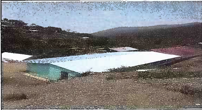
Foto1: Sustitucion de Laminas
