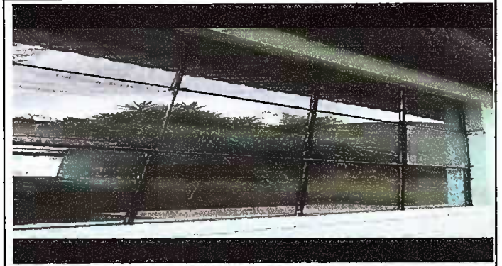
Foto 4: Colocación de marcos de ventana y vidrios
