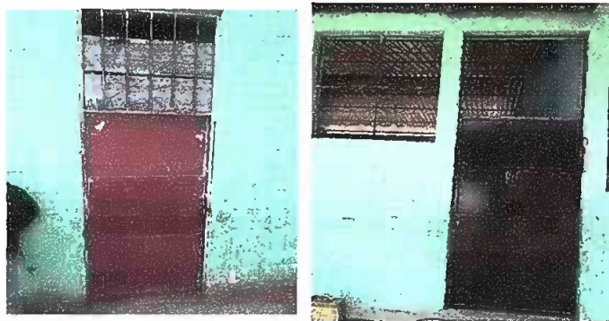
Foto 5: Laminas Colocadas y puertas
