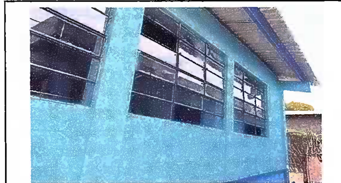
Foto 4: sustitución de vidrios
