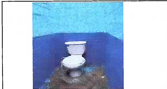
Foto 3: sustitución de inodoro
