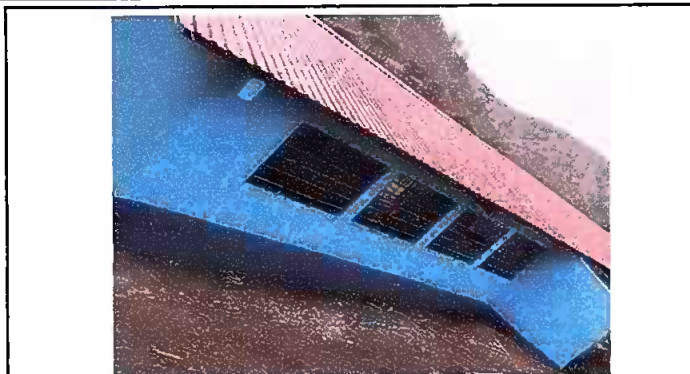
Foto1: sustitución de láminas, capotes
