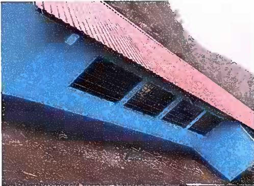
Foto 1: sustitución de láminas, capotes
