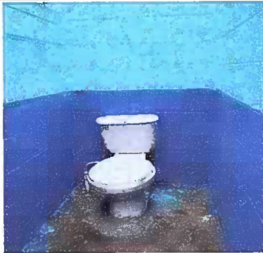
Foto 3: sustitución de inodoro
