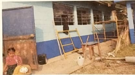
Foto 4: sustitución de vidrios
