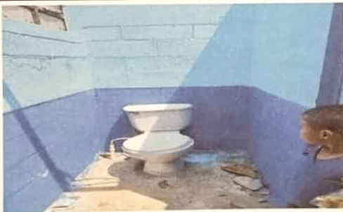
Foto 3: sustitución de inodoro
