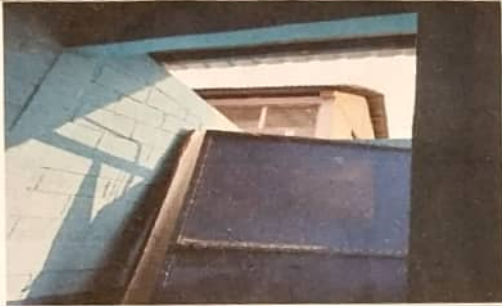
Foto1: sustitución de láminas, capotes
