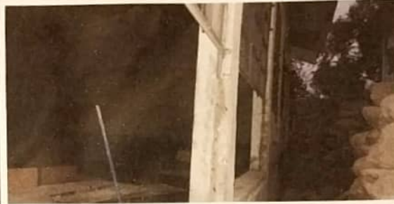
Foto 2: reparación de muro
