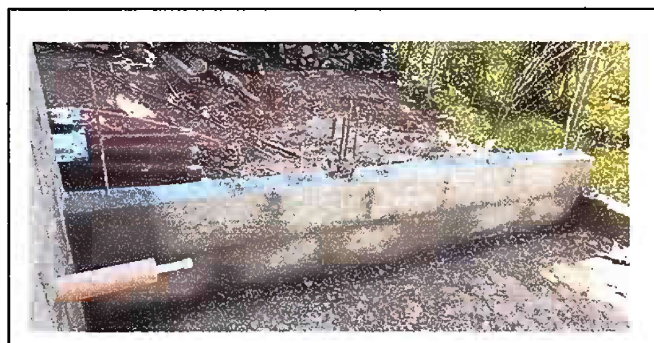
Foto 11. áreas exteriores: Reparación en block (incluye columnas)
