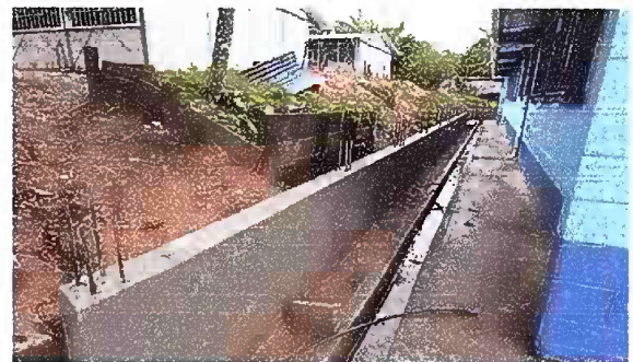
Foto 12. áreas exteriores: reparación de muro perimetral
