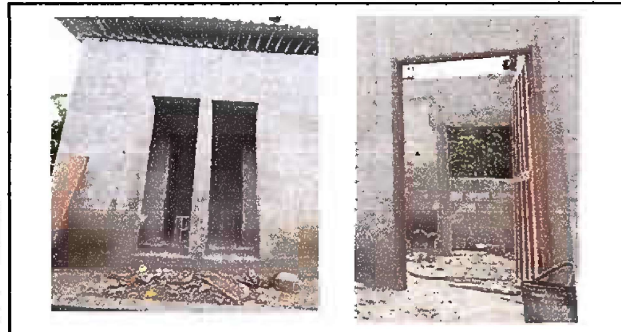
Foto 3. Modulo 3: Modulo 3: suministros e sustitución de puerta de metal
