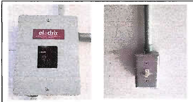
Foto 7. Modulo 3: sustitución interruptores dobles
