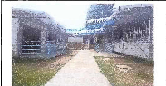
Foto 10. patio: reparación de piso de torta de concreto
