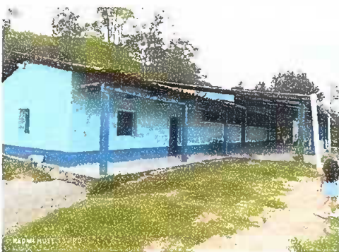
Foto 9: PINTURA EN MUROS EXTERIORES E INTERIORES. MÓDULO 1.
