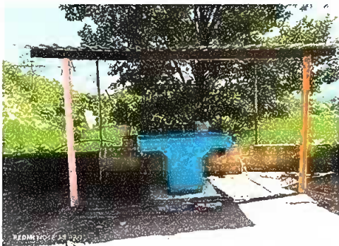
Foto 7: SUSTITUCIÓN DE PILA. MÓDULO 2.
