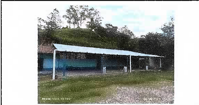
Foto 1: SUSTITUCIÓN DE LÁMINA, POR LÁMINA TROQUELADA. MÓDULO
