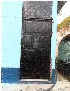
Foto 15: SUSTITUCIÓN DE PUERTAS DE METAL. MÓDULO 1.
