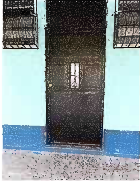
Foto 13: SUSTITUCIÓN DE PUERTAS DE METAL, MÓDULO 1.
