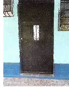
Foto 14: SUSTITUCIÓN DE PUERTAS DE METAL. MÓDULO 1.
