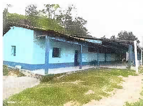
Foto 10: PINTURA EN MUROS EXTERIORES E INTERIORES. MÓDULO 1.
