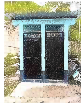
Foto 16: SUSTITUCIÓN DE PUERTAS DE METAL. MÓDULO 1.
