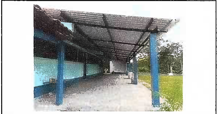
Foto 2: SUSTITUCIÓN DE LÁMINA, POR LÁMINA TROQUELADA. MÓDULO 1.
