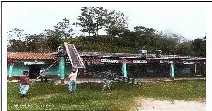
Foto 1: SUSTITUCIÓN DE LÁMINA, POR LÁMINA TROQUELADA. MÓDULO
