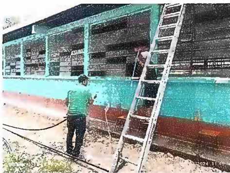
Foto 11: SUSTITUCIÓN DE VIDRIOS. MÓDULO 1.
