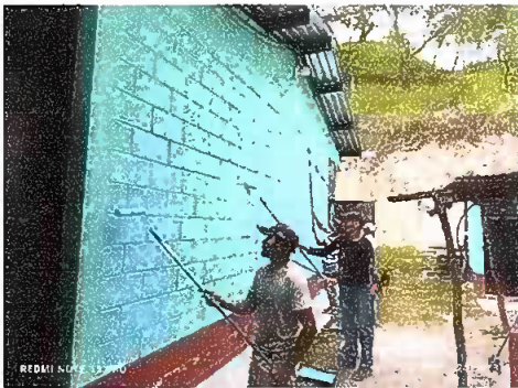
Foto 9: PINTURA EN MUROS EXTERIORES E INTERIORES. MÓDULO 1.
