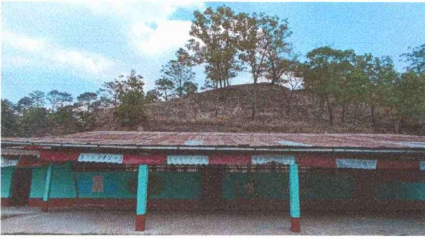
Foto 1: SUSTITUCIÓN DE LÁMINA, POR LÁMINA TROQUELADA.
