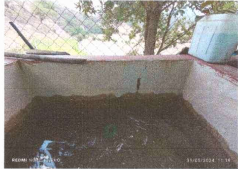
Foto 8: SUSTITUCIÓN DE PILA
