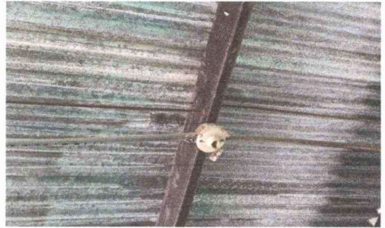
Foto 4: SUSTITUCIÓN DE LÁMPARAS TIPO LED
