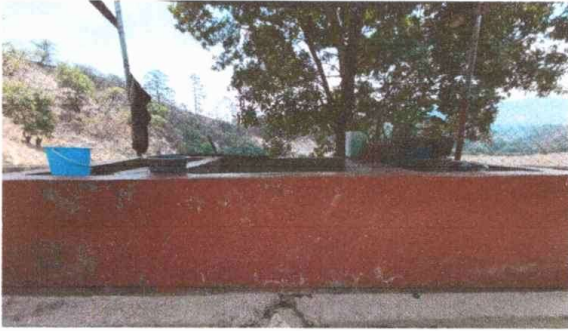
Foto 7: SUSTITUCIÓN DE PILA
