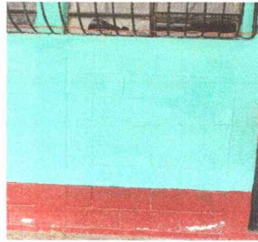
Foto 10: PINTURA EN MUROS EXTERIORES E INTERIORES
