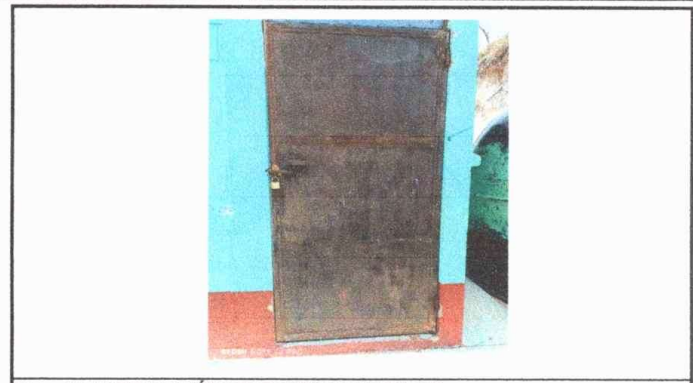
Foto 14: SUSTITUCIÓN DE PUERTAS DE METAL
