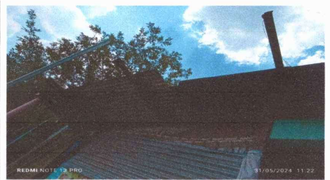
Foto 2: SUSTITUCIÓN DE LÁMINA, POR LÁMINA TROQUELADA.
