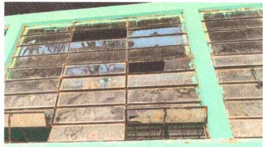
Foto 12: SUSTITUCIÓN DE VIDRIOS
