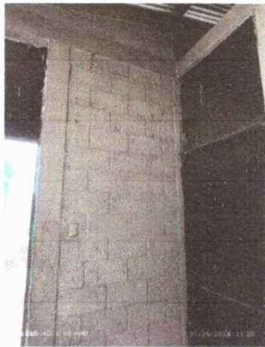
Foto 9: PINTURA EN MUROS EXTERIORES E INTERIORES
