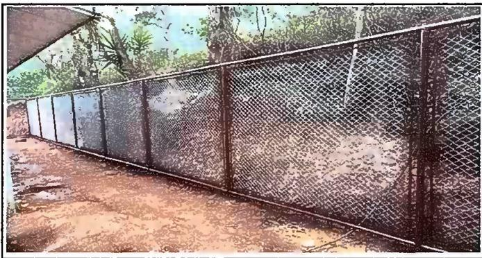
Foto 5: Sustitución de circulación de malla galvanizada calibre 12 de pulgada y media y tubo HG de pulgada y media, Sustitución de portón de metal; despues de la acción.
