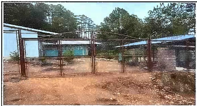
Foto 6: Sustitución de circulación de malla galvanizada calibre 12 de pulgada y media y tubo HG de pulgada y media, Sustitución de portón de metal; despues de la acción.
