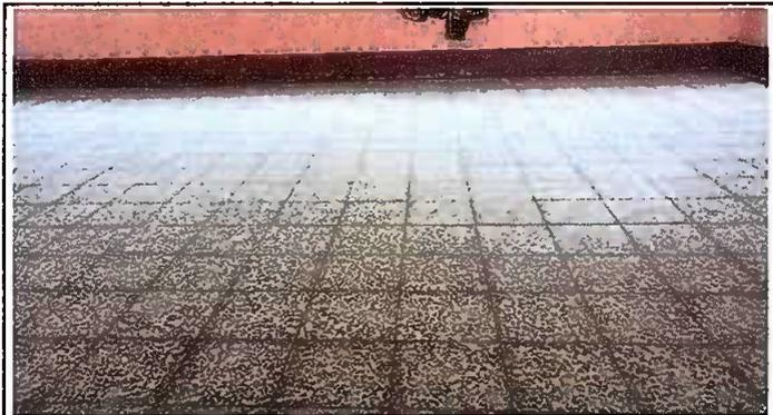
Foto 3: Sustitución de piso de torta de concreto a piso de granito; despues de la acción.
