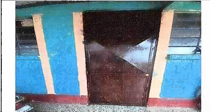
Foto 1: Mantenimiento a estructura de puertas (lijado, sujeciones y aplicación de pintura), Sustitución de chapas; despues de la acción.
