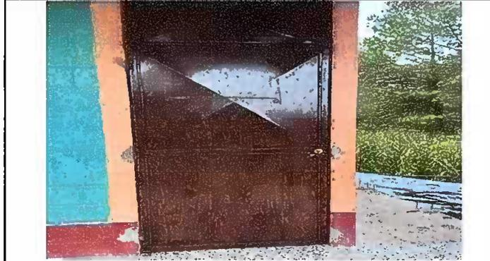
Foto 2: Mantenimiento a estructura de puertas (lijado, sujeciones y aplicación de pintura), sustitución de chapas; despues de la acción.
