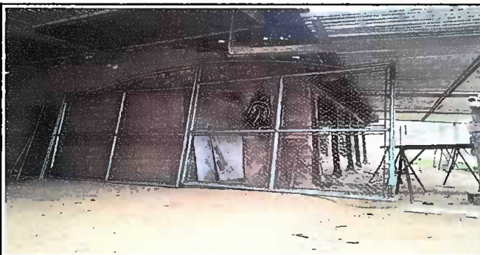
Foto 6: Sustitución de circulación de malla galvanizada calibre 12 de pulgada y media y tubo HG de pulgada y media, Sustitución de portón de metal; durante la acción.
