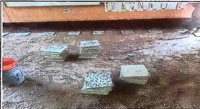
Foto 4: Sustitución de piso de torta de concreto a piso de granito; durante la acción.
