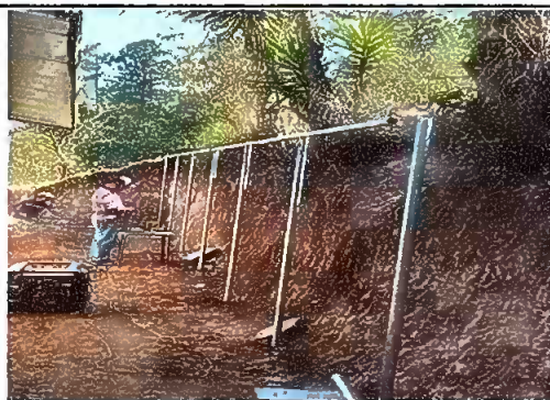
Foto 5: Sustitución de circulación de malla galvanizada calibre 12 de pulgada y media y tubo HG de pulgada y media, Sustitución de portón de metal; durante la acción.
