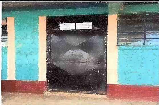
Foto 1: Mantenimiento a estructura de puertas (lijado, sujeciones y aplicación de pintura), Sustitución de chapas; antes de la acción.
