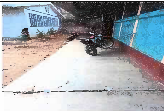
Foto 4: Sustitución de piso de torta de concreto a piso de granito, antes de la acción.
