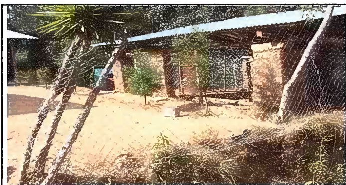
Foto 5: Sustitución de circulación de malla galvanizada calibre 12 de pulgada y media y tubo HG de pulgada y media, Sustitución de portón de metal, antes de la acción.
