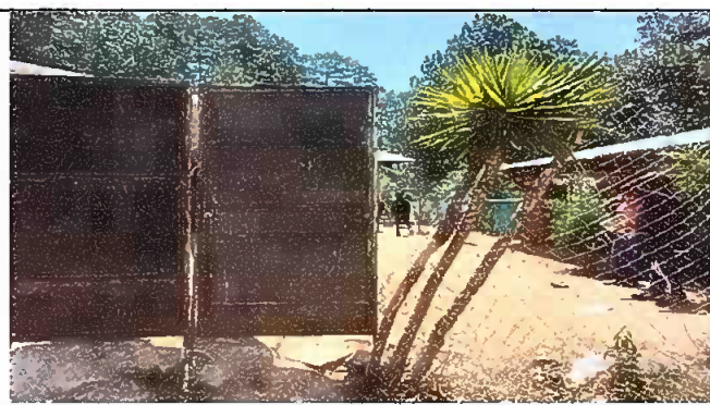
Foto 6: Sustitución de circulación de malla galvanizada calibre 12 de pulgada calibre 12 de pulgada y media y tubo HG de pulgada y media, Sustitución de portón de metal, antes de la acción.
