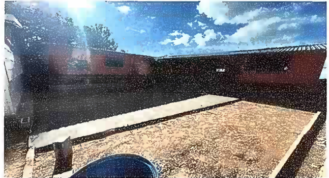
Foto 2: MODULO II: SUSTITUCIÓN DE PISO DE TORTA DE CONCRETO
