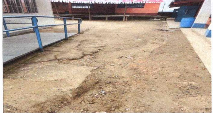
**Foto 2: SUSTITUCIÓN DE PISO DE TORTA DE CONCRETO**
