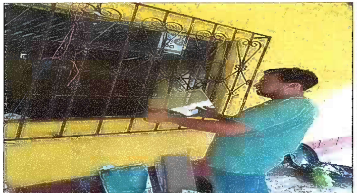
Foto 4: MÓDULO I. SUSTITUCIÓN DE VIDRIOS
