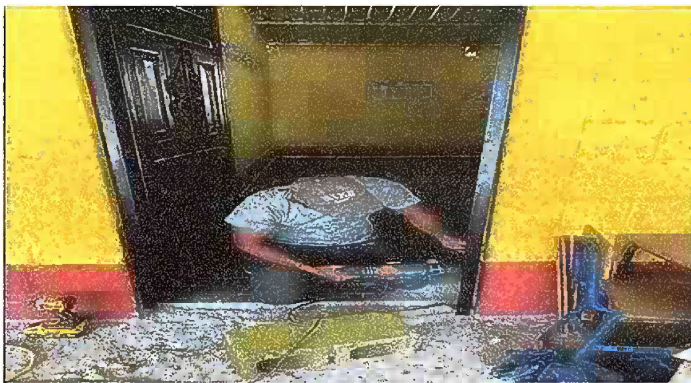
Foto 3: MÓDULO I. SUSTITUCIÓN DE PUERTA DE METAL
