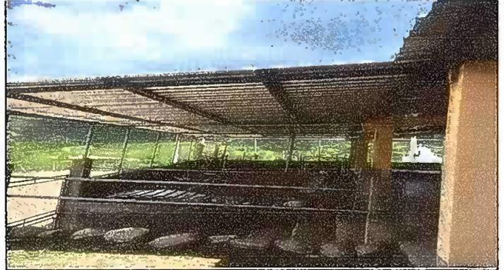
Foto 4: Modulo I. Instalación de lamina troquelada aluzinc
