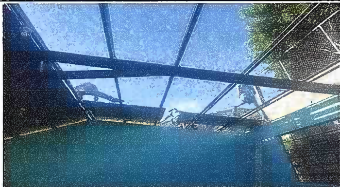
Foto1: Modulo I. Sustitución de lámina, por lamina troquelada aluzinc calibre 2
