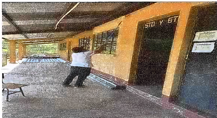
Foto 3: Modulo I. Pintura en muros exteriores e interiores
