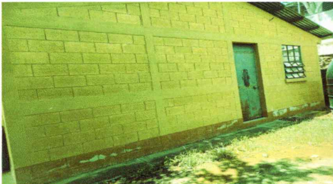
Foto 3: MODULO I. PINTURA EN MUROS INTERIORES E EXTERIORES
