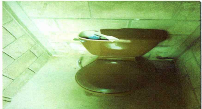
Foto 4: MODULO II. SUSTITUCION DE INODORO CON SUS ACCESORIOS
