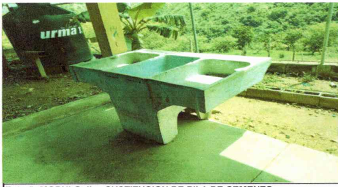
Foto 5: MODULO II. SUSTITUCION DE PILA DE CEMENTO
