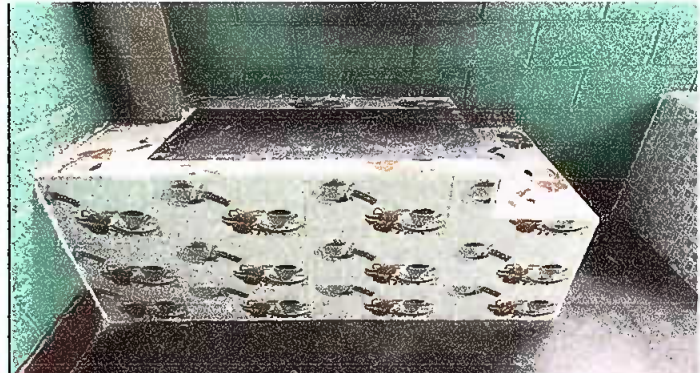
Foto 4: MODULO I: SUMINISTRO E INSTALACIÓN DE AZULEJO DE PLANCHA
