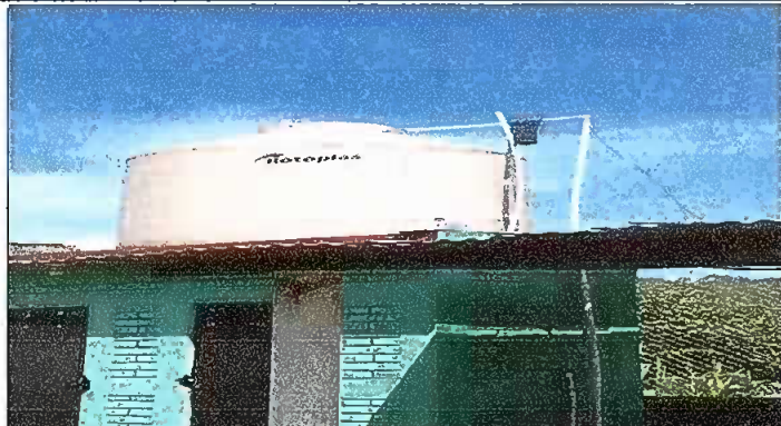
Foto1: MODULO II: SUMINISTRO DE TINACO CON SUS ACCESORIOS
