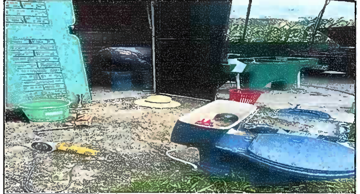
Foto 2: MODULO II: SUSTITUCION DE INODORO CON SUS ACCESORIOS
