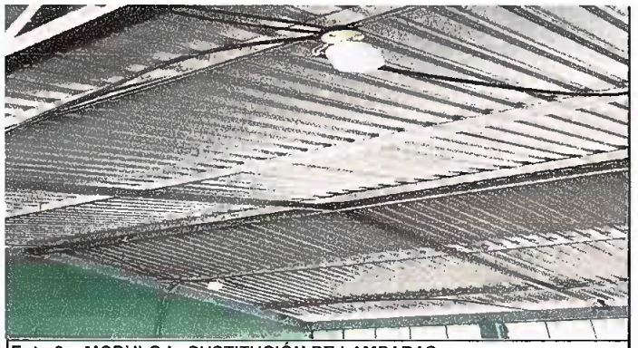
Foto 6: MODULO I: SUSTITUCIÓN DE LAMPARAS
