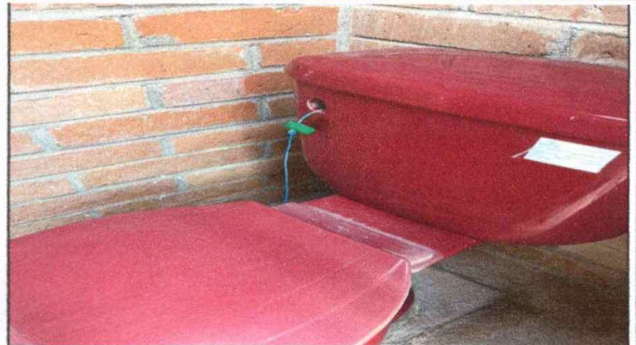
Foto 2: SUSTITUCION DE INODORO CON SUS ACCESORIOS
