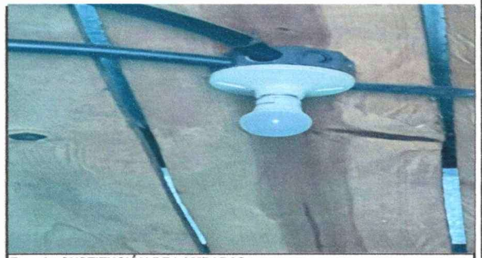
Foto 6: SUSTITUCIÓN DE LAMPARAS
