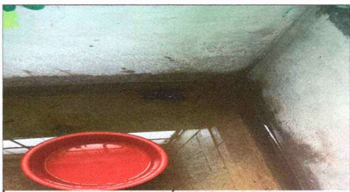
Foto 5: SUMINISTRO E INSTALACIÓN DE AZULEJO EN PILA
