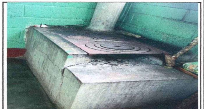
Foto 4: SUMINISTRO E INSTALACIÓN DE AZULEJO DE PLANCHA
