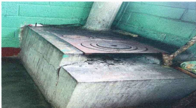
Foto 3: SUSTITUCIÓN DE PLANCHA DE METAL, DE 3 HORNILLAS
