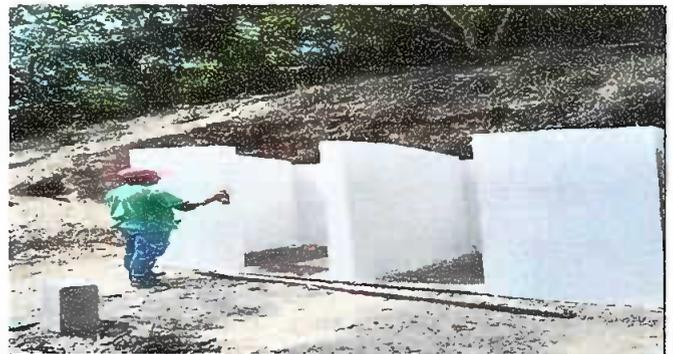
Foto 6: MODULO II. REPELLO EN MURO
