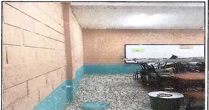
Foto 16: PINTURA EN UROS EXTERIORES E INTERIORES MODULO I
