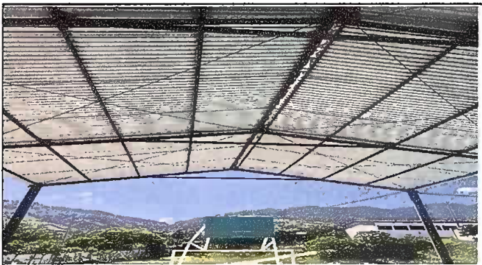
Foto 9: INSTALACIÓN DE LÁMINA TROQUELADA AZULINK.(INCLUYE ANDAMIO) MODULO II.
