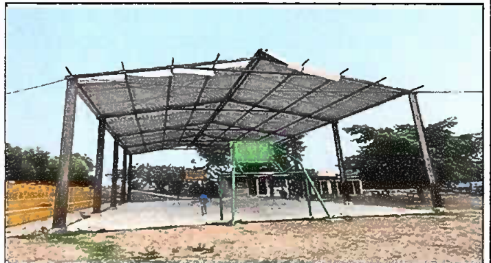
Foto 4: SUSTITUCIÓN DE LÁMINA POR LÁMINA TROQUELADA AZULINK CALIBRE 26 MODULO II.
