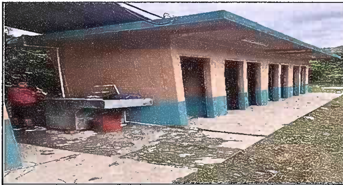
Foto 17: PINTURA EN UROS EXTERIORES E INTERIORES MODULO IV
