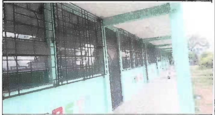
Foto 2: SUMINISTRO E INSTALACIÓN XDE BALCONES DE METAL MODULO I.
