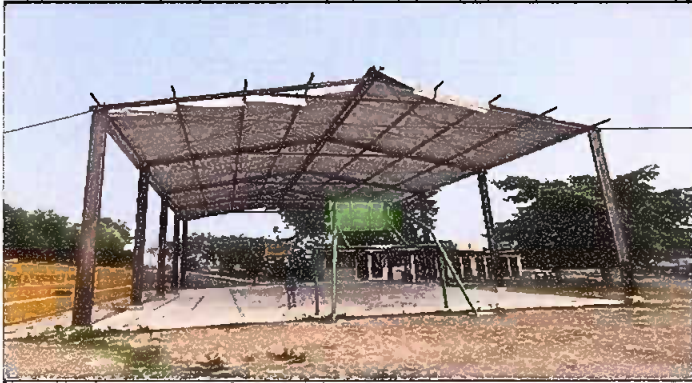
Foto 7: DESINSTALACIÓN SDE LÁMINA EXISTENTE) MODULO II.
