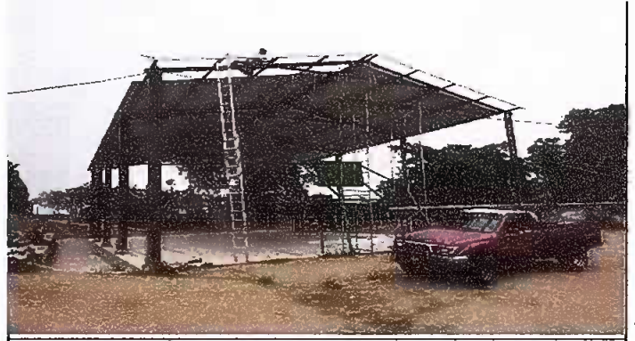
Foto 8: REPARACIÓN DE STRUCTURA DE SOPORTE DE METAL(CORTA VIENTOS MODULO II.
