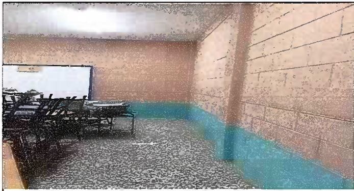
Foto 15: . PINTURA EN UROS EXTERIORES E INTERIORES MODULO I
