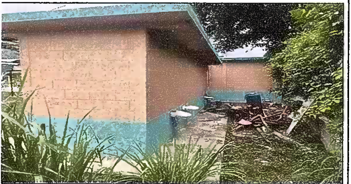
Foto 18: PINTURA EN UROS EXTERIORES E INTERIORES MODULO IV
