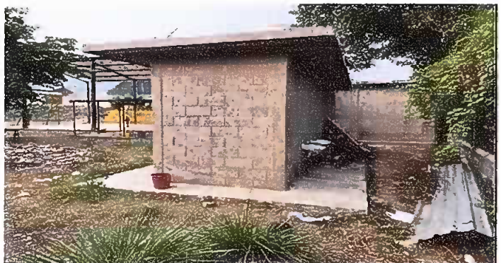
Foto 18 PINTURA EN UROS EXTERIORES E INTERIORES
