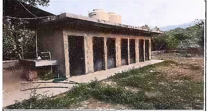
Foto 14: PINTURA EN UROS EXTERIORES E INTERIORES
