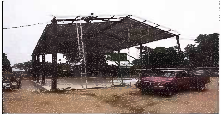
Foto 8: REPARACIÓN DE STRUCTURA DE SOPORTE DE METAL(CORTA VIENTOS MODULO II.
