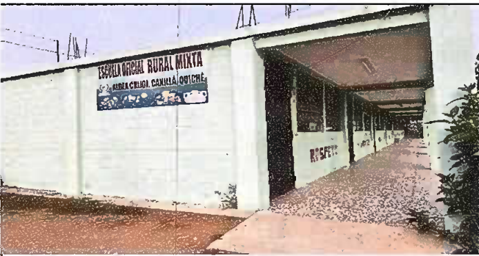
Foto 17: PINTURA EN UROS EXTERIORES E INTERIORES
