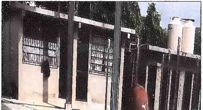
Foto 10: SUSTITUCIÓN DE PUERTAS90X2.64) MODULO III.
