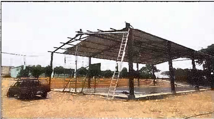
Foto 7: DESINSTALACIÓN SDE LÁMINA EXISTENTE) MODULO II.
