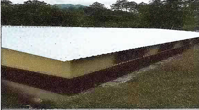
Foto 1: MÓDULO I. SUSTITUCIÓN DE LÁMINA, POR LÁMINA TROQUELADA ALUZINC CALIBRE 26
