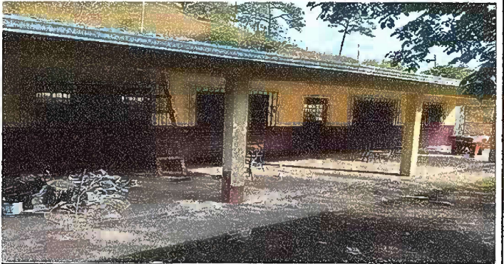
Foto 6: MÓDULO I. PINTURA EN MUROS EXTERIORES E INTERIORES
